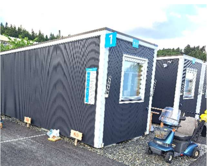
仮設住宅(5月)。内部は木材が使用され、住み心地の良い住居となっている
