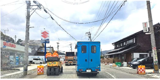
輪島市街、3月13日。目の前で、様々な補修が進められている。行きにあった陥没が、帰りにはアスファルトで埋められていた。
