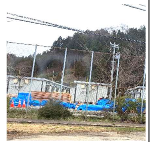
建設中の仮設住宅。東北の復興も、まずこの建物が作られてから始まった。
