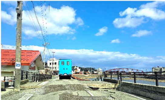
3月の輪島市内。陥没部分は埋められているが、ただ走るだけで車軸がゆがむほどの悪路だ
